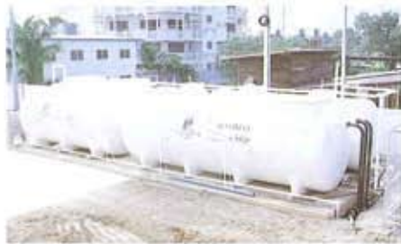
ติดตั้งบนพื้น (ON GROUND) : LOTUS มีนบุรี
